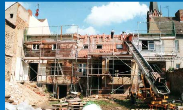
Sanierung von Wohnungsbestand
